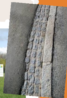
Réfection des joints de caniveaux à St- Pierre-sur-Orthe
